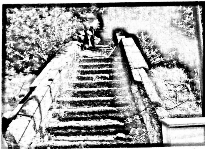
LE CONDIZIONI DI UNA DELLE SCALE INTERNE ALLA STRUTTURA
